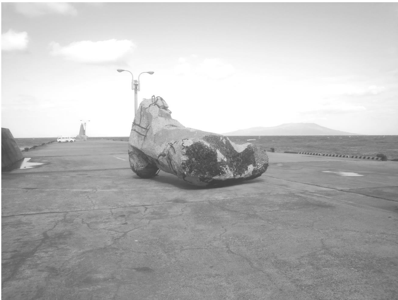
台風26号によって桟橋に打ち上げられた防波ブロック（ドロス）
